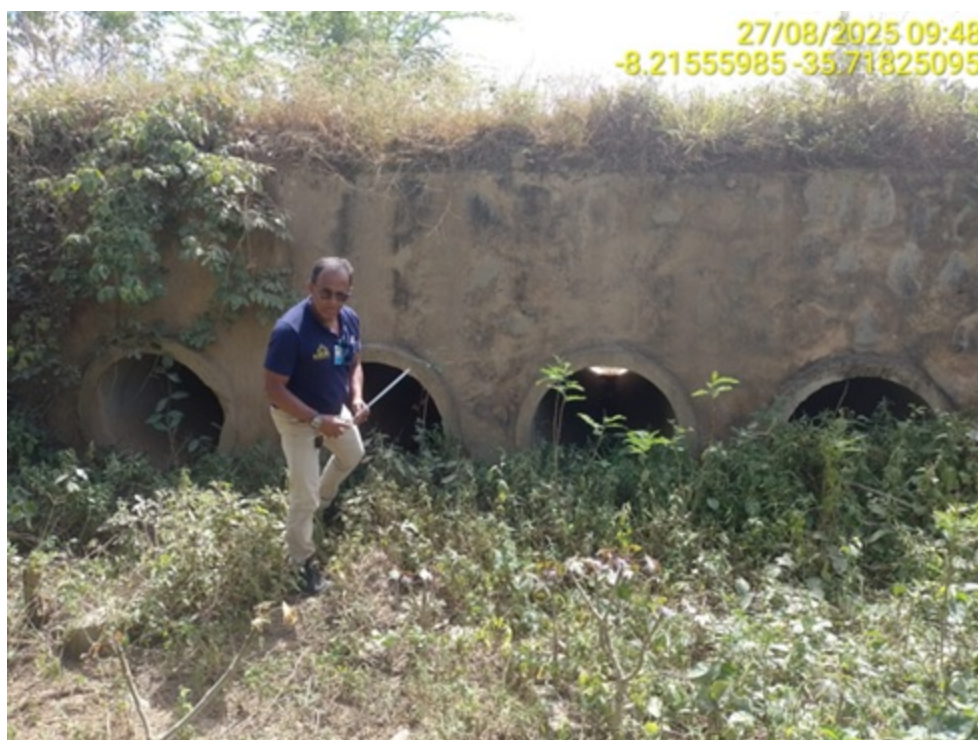
Figura 17: Bueiro quádruplo tubular de concreto com d=1,0m
