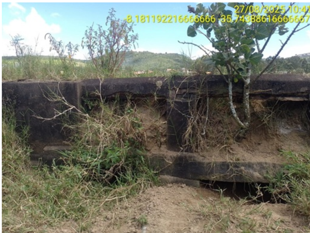
Figura 18: Bueiro triplo celular de concreto
